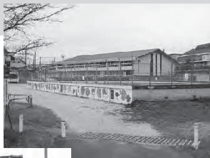
耐震化された体育館
