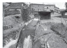
18区用水水漏整備
