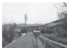
18区道路路肩整備
