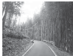
瀬戸地区道路拡幅整備
