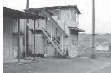
改修される第3部瀬戸詰め所
